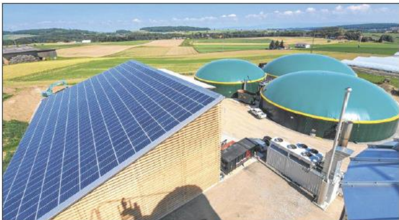
L'Energiepark de Guin regroupe une centrale à biogaz (à droite) et une halle de production de «pellets» dont le toit est garni de 800 m 2 de panneaux photovoltaïques. ALDO ELLENA
